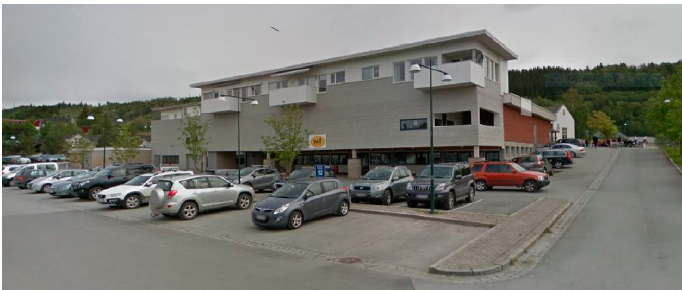
Figur 3 Bilde som viser bebyggelse i BS7 sin vestlige side
